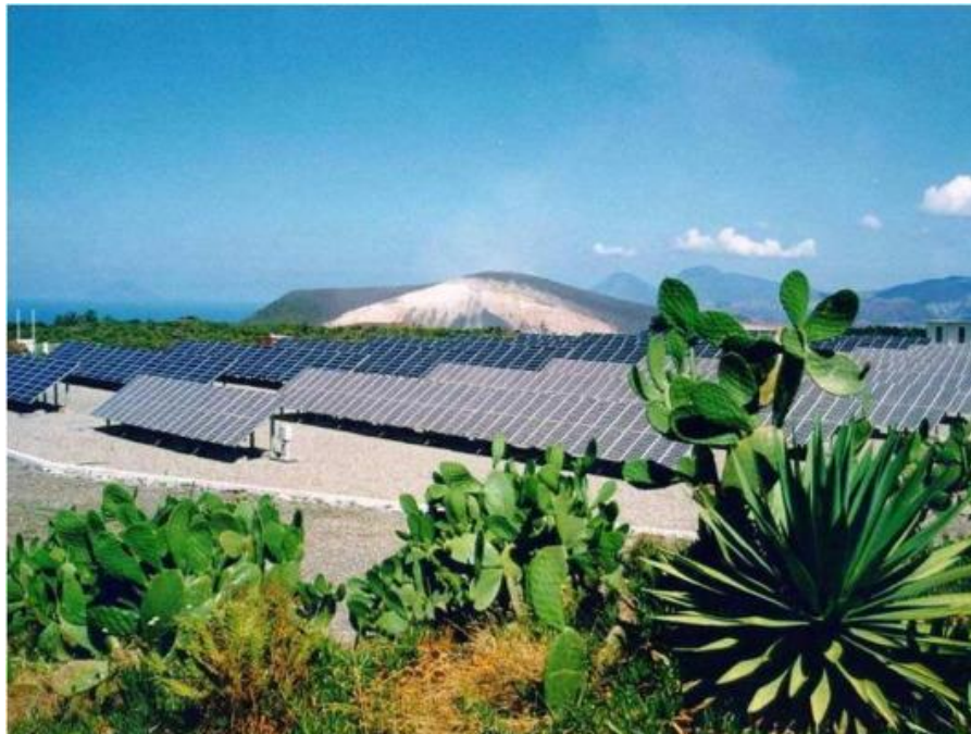
Figura 33 – Sistema solar pioneiro na ilha de Vulcano, com 180kW.
